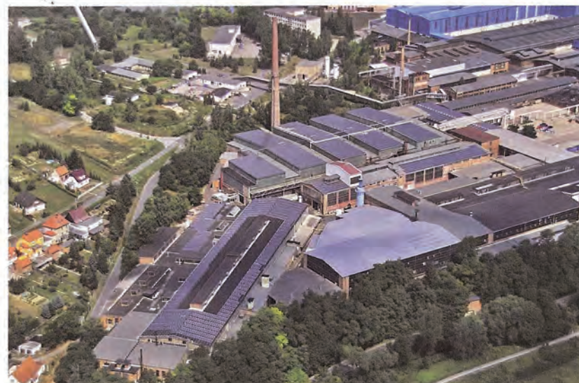
Alle Dächer der Aluwerk Hettstedt GmbH sind mit Solarmodulen belegt. Die Anlage liefert bereits seit Sommer Strom ins öffentliche Netz.
